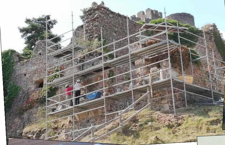
Chantier de la Diana au château
